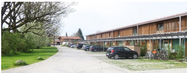
Wohngruppe in Münsing, im April 2022 – Fertigstellung 2017
