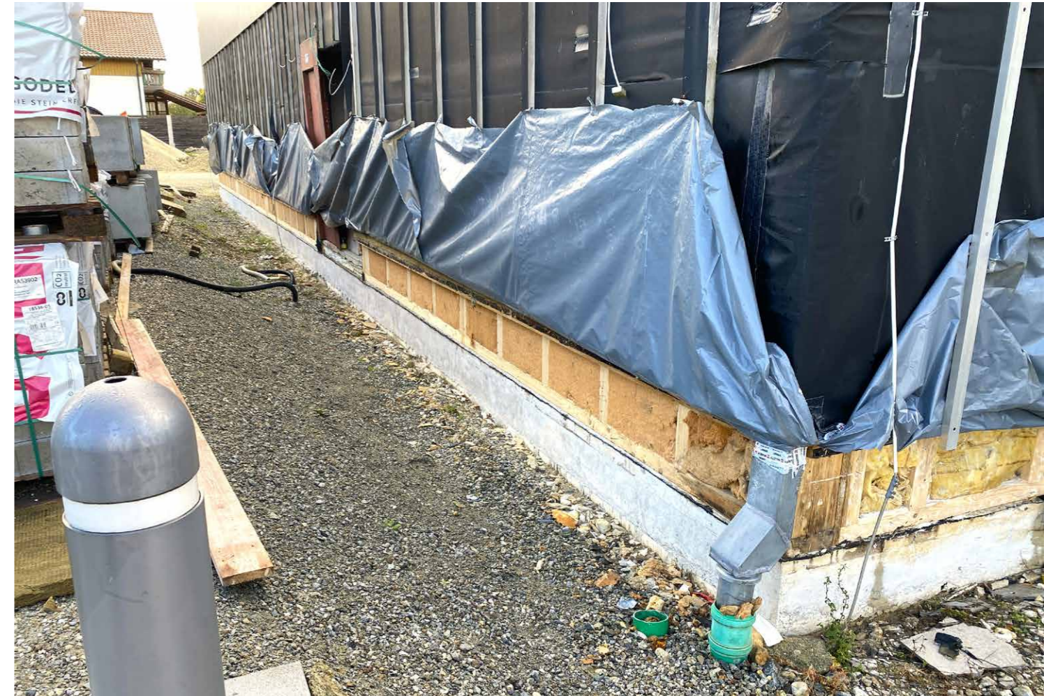
Das Bild zeigt die Arbeiten am Sockel der Halle, dieser wird komplett neu abgedichtet.
